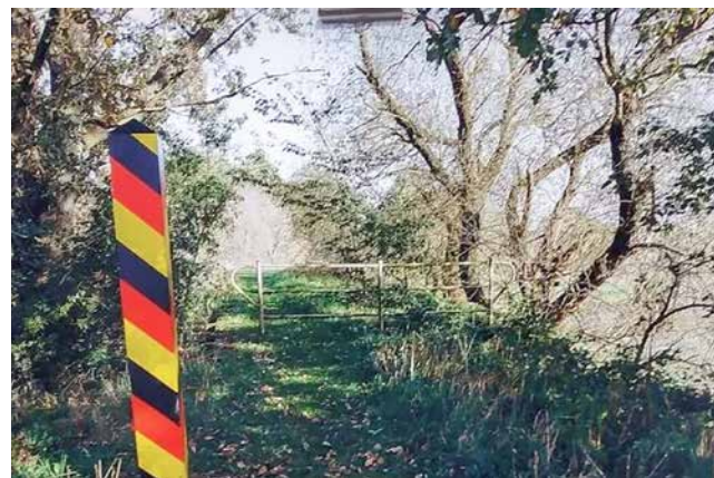
Polskę i Niemcy łączą 43 mosty i kładki na rzekach granicznych.
