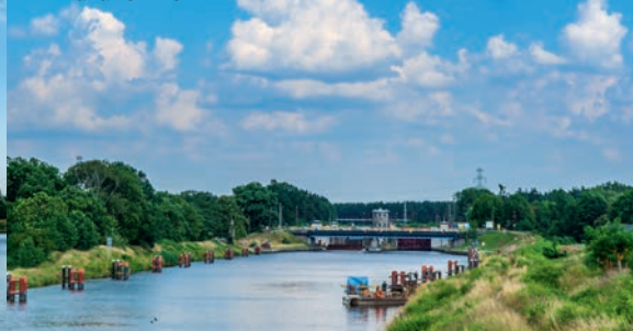
Gleitwitzer Kanal Kanał Gliwicki
