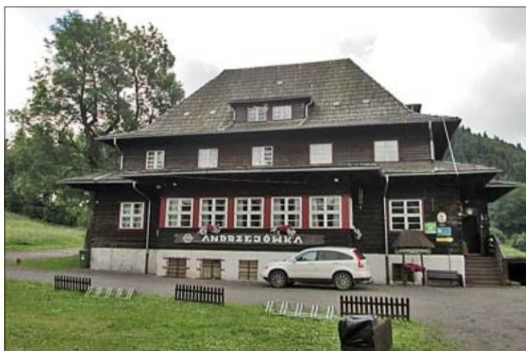
Die Andreasbaude ist seit 1933 eine der schönsten Berghütten in den Sudeten
