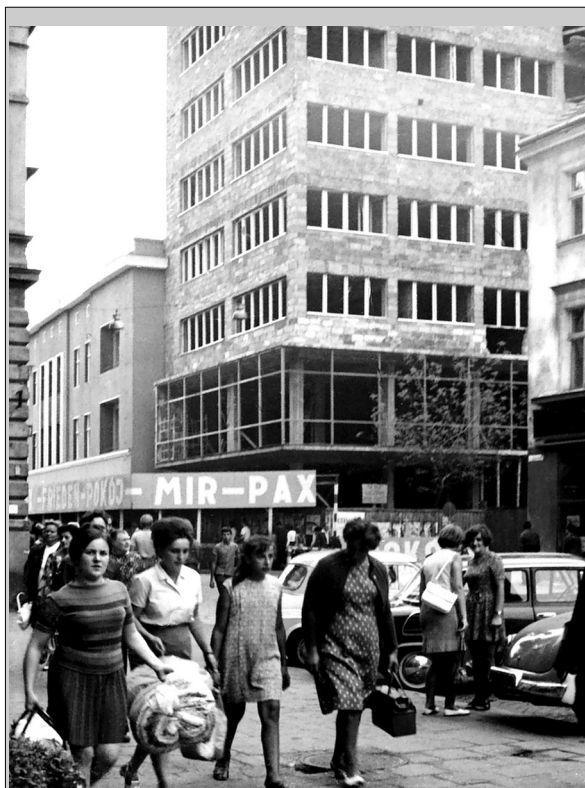
30. Gmach "Empiku" w trakcie budowy, lata 1966-67, fot. S. Bober, zbiory Muzeum Śląska Opolskiego.
